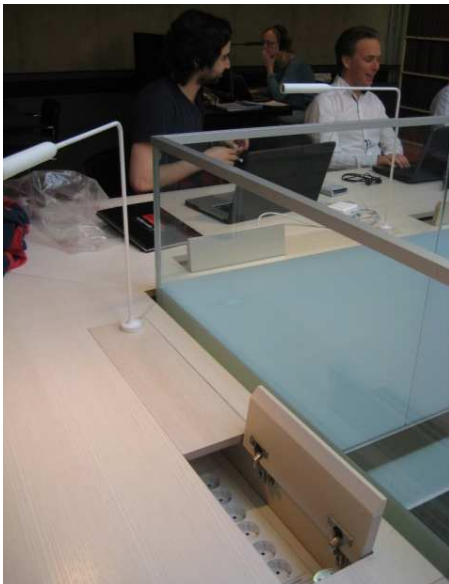
Figura 27: Les connexions estan en l'espai de treball, protegides i sense cap cable a la vista.
