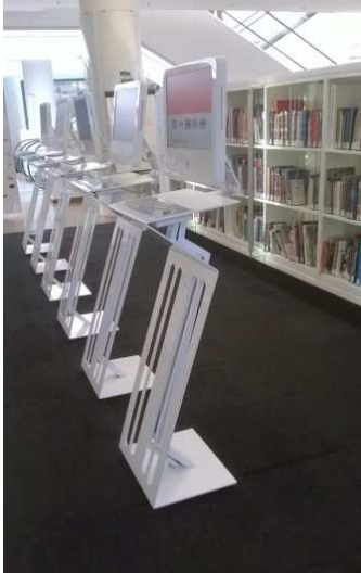
Figura 24: Les connexions i els cables estan completament amagats.
